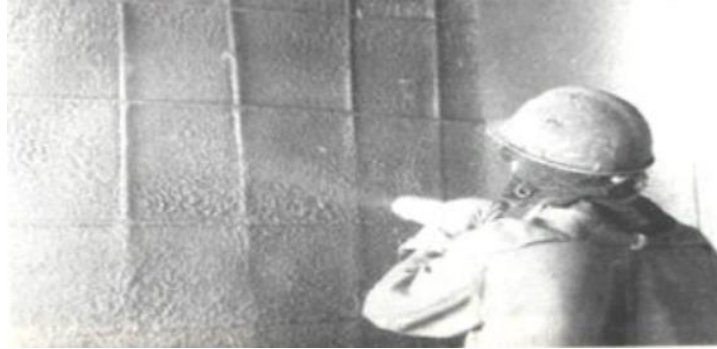
Figure I.7 : Béton de sable en projection - Projection du béton sur vieille surface avec nouveau ferrailage (Sablocrete 1994).
