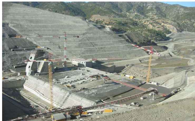
Figure II.2 : Barrage de Koudiat-Acerdoune –Algérie (au cours de la construction) (Forbes 2007).
