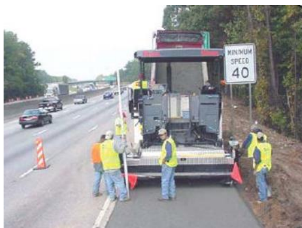
Figure II.4 : Mise en place du BCR en pavage - Atlanta USA (Zdiri 2008).
