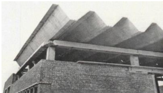
Figure I.6 : Utilisation du béton de sable dans la préfabrication (Sablocrete 1994).
