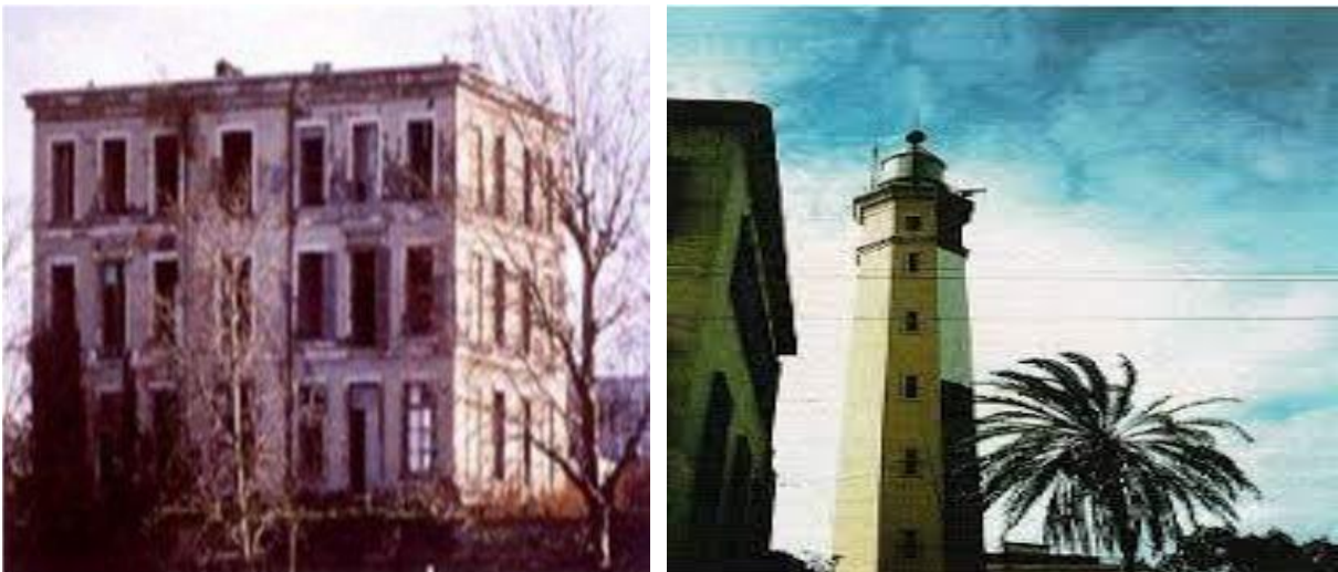
Figure I.2 : Maison de François Coignet à Saint en France, et Phare de Port-Saïd en Egypte (Sablocrete 1994).
