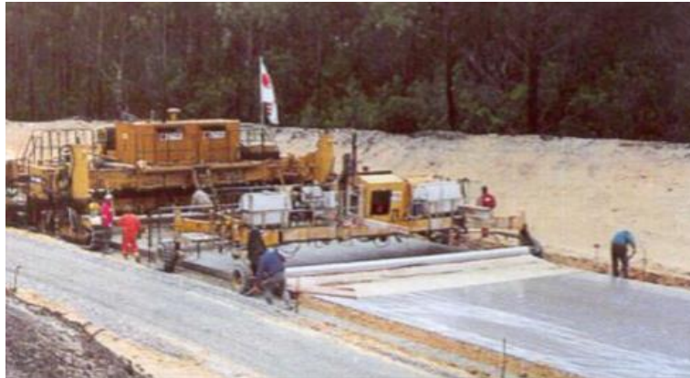
Figure I.5 : Application du béton de sable dans le domaine routier (Sablocrete 1994).
