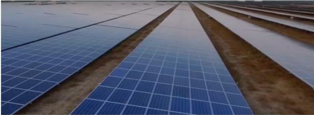
Fig I.12 : La plus grande centrale solaire au monde en 2016 (Kamuthi-Inde) [38]
