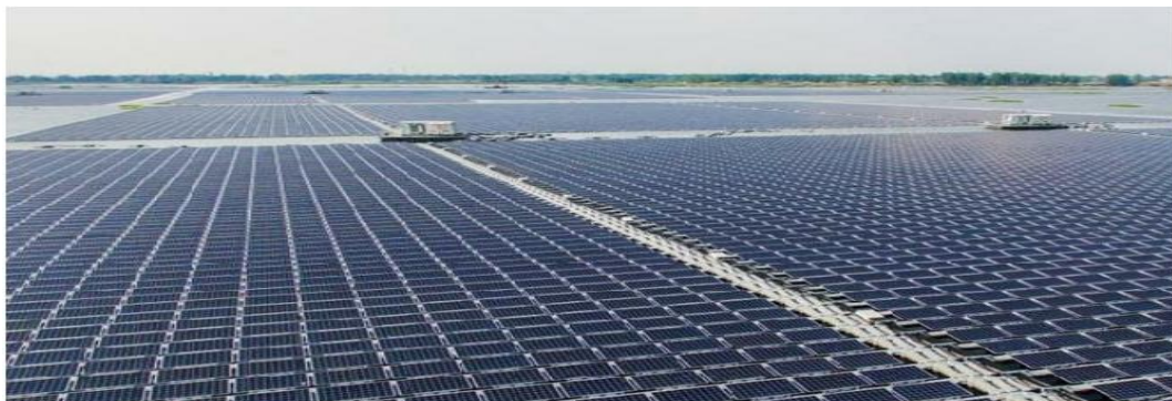
Fig I.11 : La plus grande centrale PV au monde (Chine, 2017) [37]
