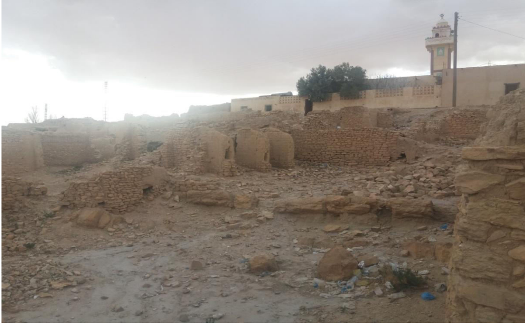
صورة 09 توضح حالة التدهور التي تعرض لها مسكن القصر
