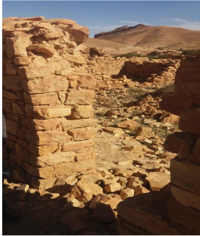
صورة 17 توضح سمك الجدار ونوع الحجارة المستخدمة في البناء
