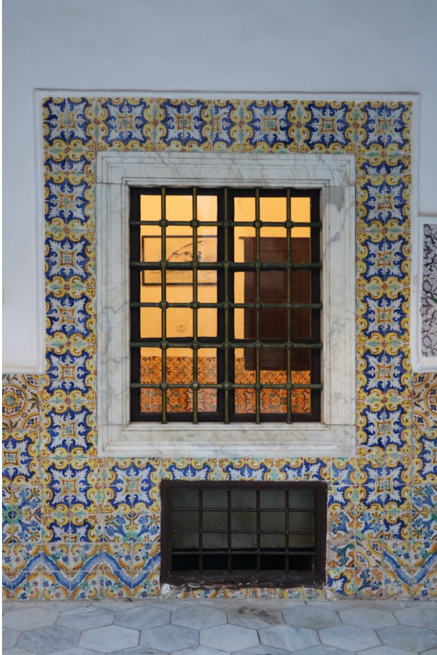
صورة 31 : إطار نافذة (نموذج 1 من الطابق الأرضي)
