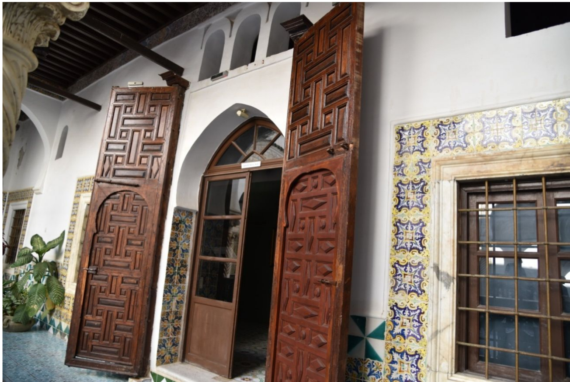
صورة 20 : مدخل غرفة المعيشة (طابق أول)
