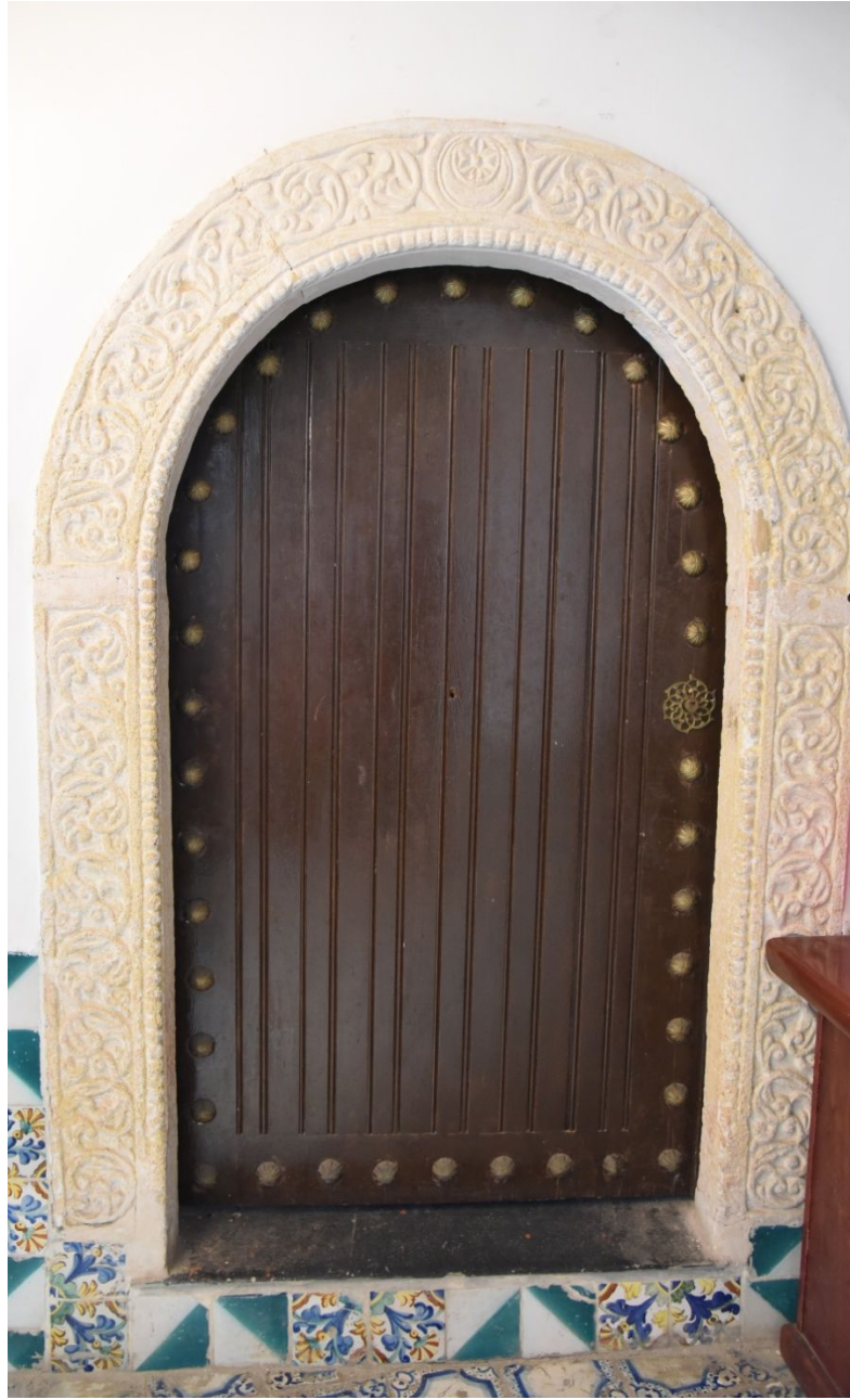
صورة 24 : مدخل غرفة الخدم (الطابق الثاني)
