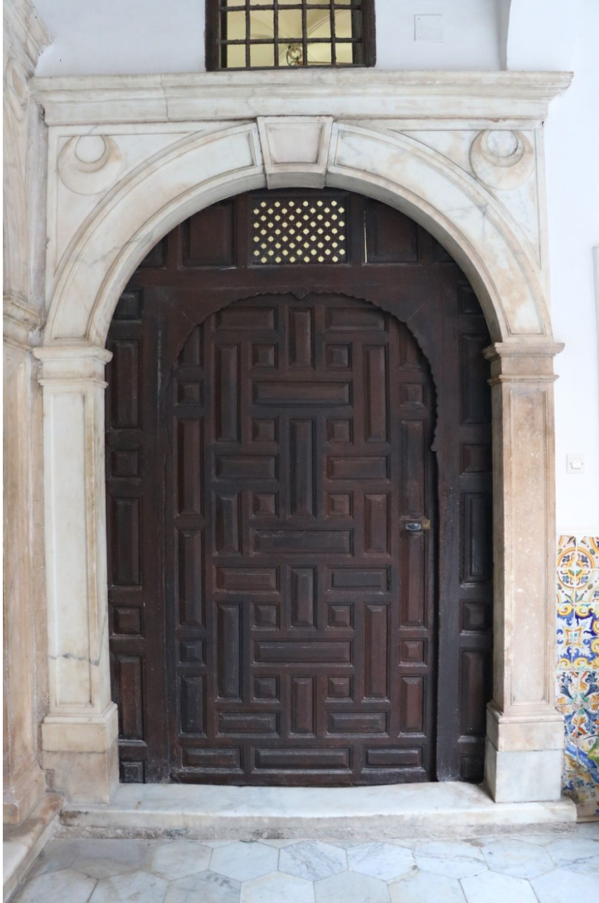
صورة 08 : مدخل الفناء المركزي
