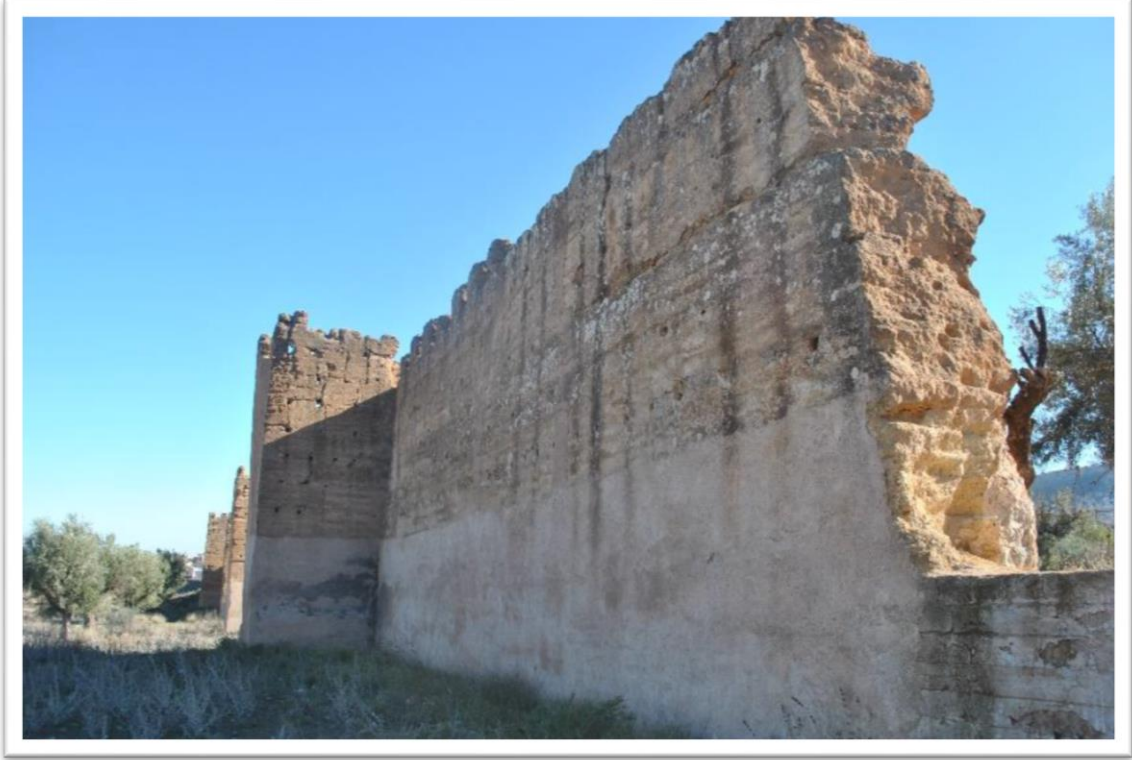
الصورة رقم 11 : السور الشمالي لمدينة المنصورة
