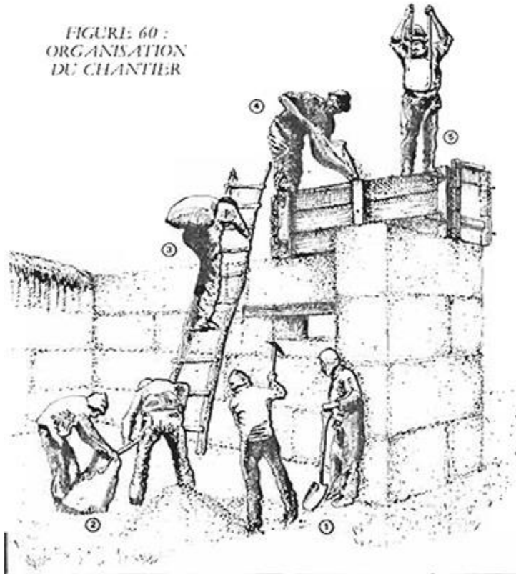
الملحق 16: العمل في بناء جدار الطابية بعد ارتفاعه
