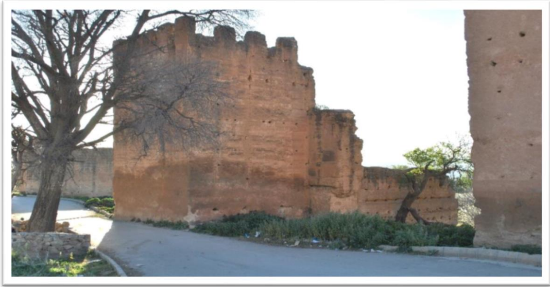
الصورة رقم 21 : الجدار الشرقي للبرج بمدينة المنصورة
