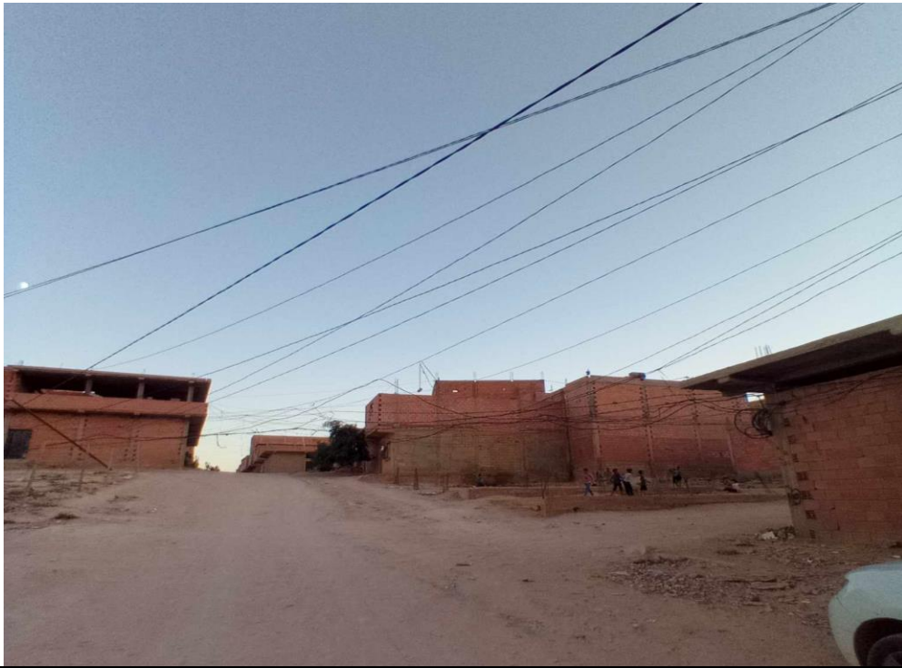
صورة رقم(17): الربط بشبكة الكهرباء(حي بن سعيد)
