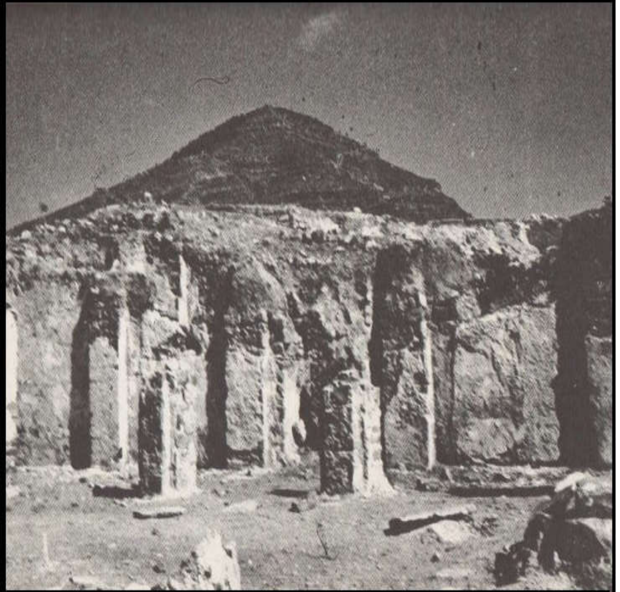
الملحق رقم 01 : آثار قصر المنار بقلعة بني حماد رشيد بورويبة و آخرون، المرجع السابق، ص: 537.
