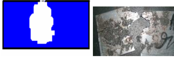
Figure I.2.9: corrosion par piqûre [20] .
