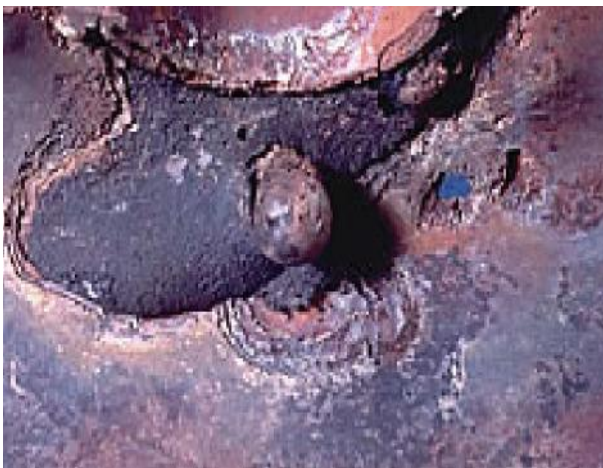
Fig. (I.7): Corrosion galvanique au niveau d'une zone de brasage entre la brasure Cu-P et le tube en cuivre.
