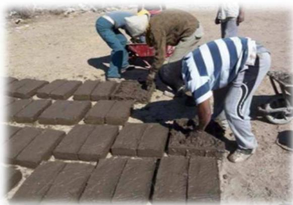
**Photo 1.1.***Moulage et séchage des blocs adobes*
